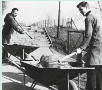
Treppenbau im Jahr 1970.
