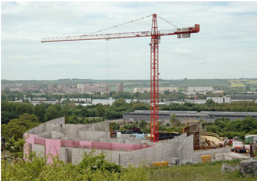
Auf der Baustelle wächst das Elefantenhaus sichtbar empor.
